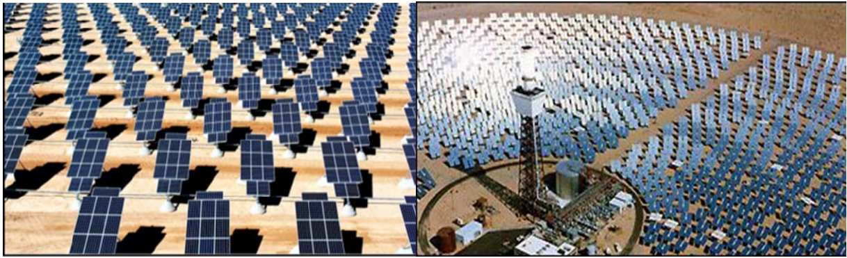
圖 1.1 太陽能發電廠
