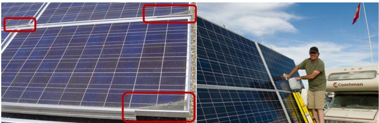
圖 1.4 室外太陽能板灰塵不可避免，清洗既費力又危險
